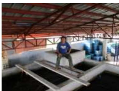
NVATのBMプラント
